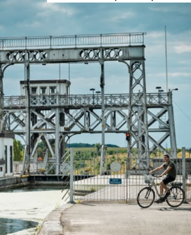
Ascenseur hydraulique n°4
